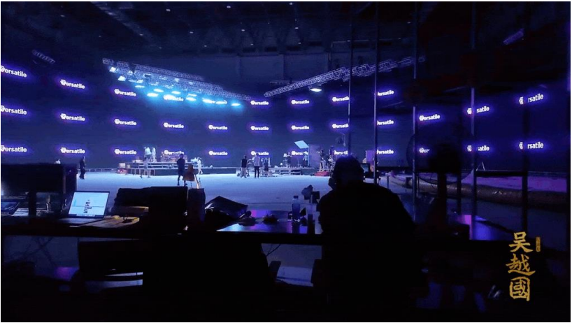
博采AI虚拟影视基地，单体直径达50米的LED虚拟影棚，设计为270度环幕，由26600块LED屏幕组成，总像素达6亿，单体影棚总面积达5000平方米
